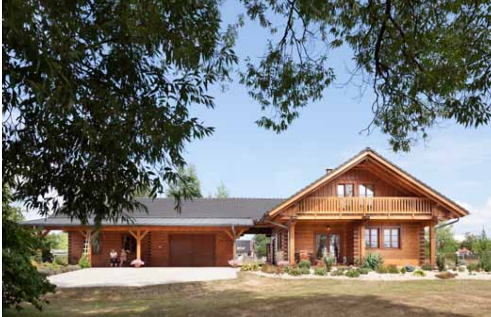
Garáž v levé části funguje také jako sklad zahradní techniky, kterou péče o hektarový pozemek vyžaduje. Původně tu stála jen ona, dům se přistavoval dodatečně
