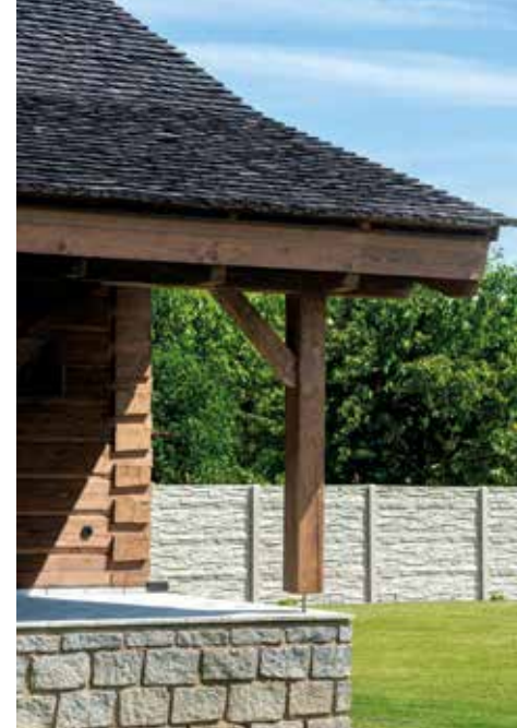
Dřevo, kámen a jednoduchý trávník stylově doplňuje střecha s modřínovými šindeli
